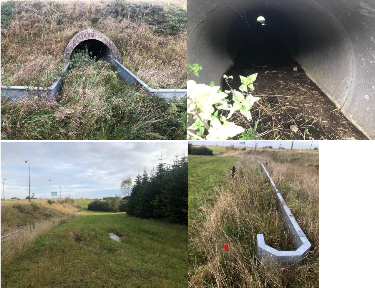
Paddehegn og -tunnel anlagt vestpå ved Høje Kjelstrupvej
